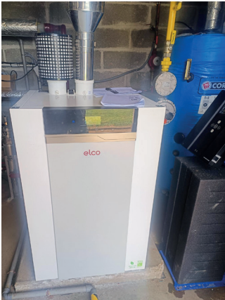
Remplacement de l'éclairage et de la chaudière du Dojo pour réaliser des économies d'énergie.
