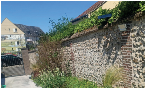
Pose de nouveaux éclairages LED solaires dans la cours de la Médiathèque.
