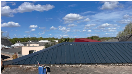
Remplacement des verrières de l'école par un bac acier, au niveau du réfectoire des maternelles.
