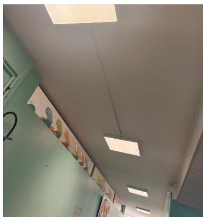
Remplacement de l'éclairage par des ampoules LED moins énergivores.
